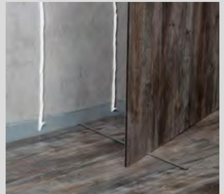
Nach Montage der Revita \_ RV Paneele sind Übergänge der Wandplatten zum Duschboden oder zur Duschanne mit Silikon abzudichten. Auch die Eckfuge zweier Paneele ist mit einer Silikonnaht fachgerecht zu versiegeln.
